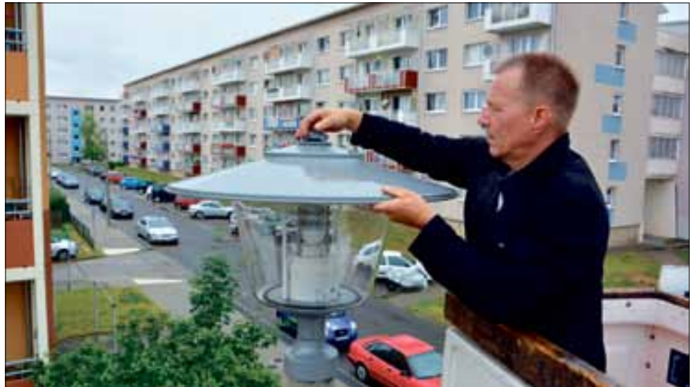
Die Straßenbeleuchtung in Eberswaldes Leibnizviertel mit stromsparenden Leuchten umgerüstet hat unter anderen Elektriker Jörg Riedel vom städtischen Bauhof.
