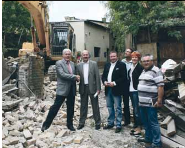
Zum Auftakt der Abbrucharbeiten der alten Brauerei trafen sich Bauherr Wilhelm Schomaker, Bürgermeister Friedhelm Boginski, Architekt Erhard Soyk, Bauordnungsamtsleiter Udo Götze, Beatrix Pohl vom Stadtentwicklungsamt und Klaus-Peter Schulz, Geschäftsführer des beauftragten Görlitzer Abrissunternehmens.
