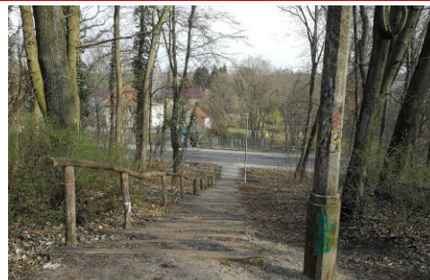
Eingangsbereich über Treppen (Osten)
