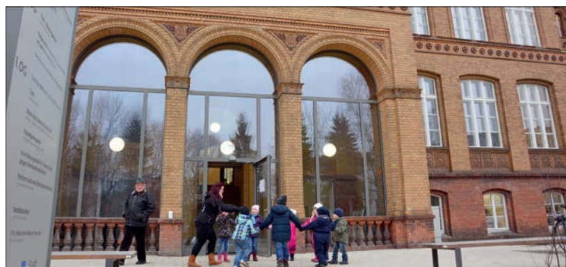
Das Bürgerbildungszentrum Amadeu Antonio ist mit Hilfe der Städtebauförderung entstanden.
