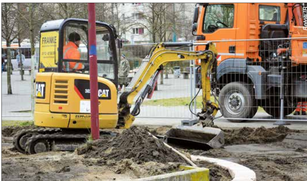
Baggern für das neue Beet: Das Brandenburgische Viertel wird mit neuem Grün aufgefrischt.
