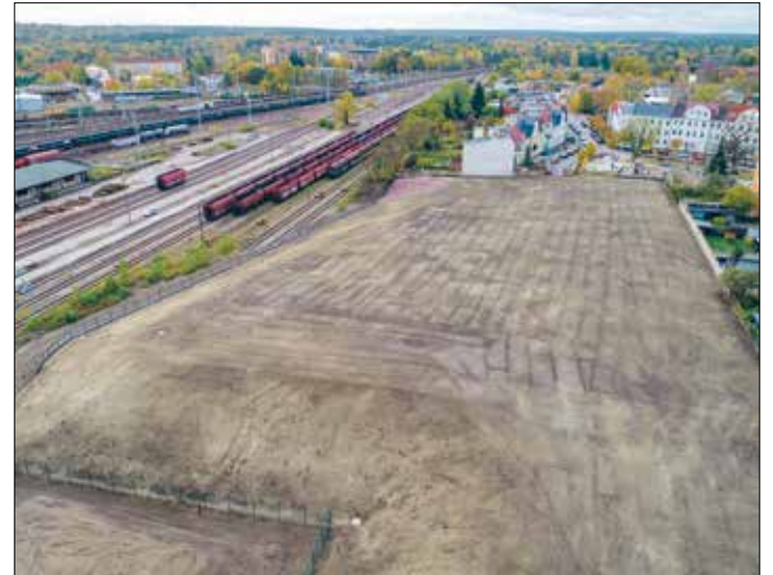
Von Januar bis Oktober konnte der Altstandort „Ehemalige Dachpappenfabrik“ saniert werden. Foto: Thomas Burckhardt
