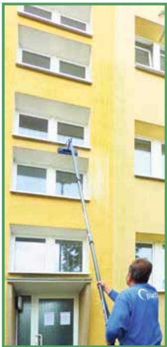
Ein Mitarbeiter der Firma Platz GmbH ist mit der Teleskopbürste in der Alexander-von-Humboldt-Straße im Einsatz.
