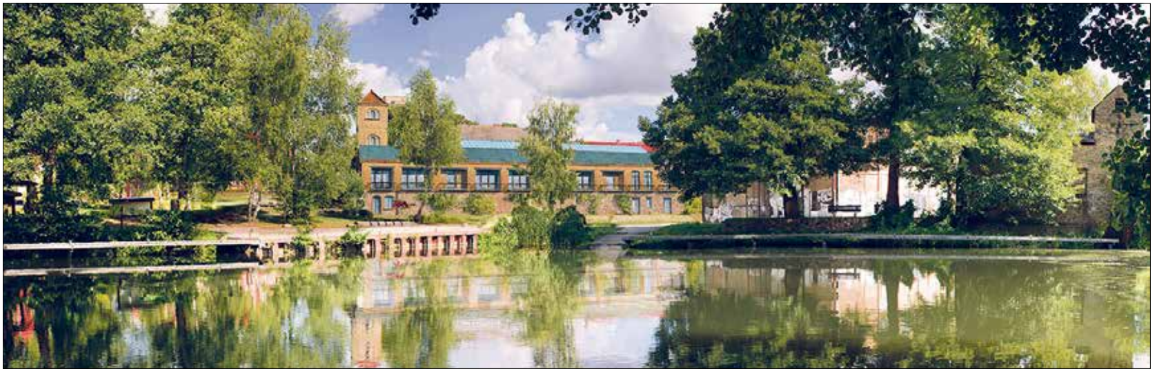
Die Halle 15 in der historischen Messingwerksiedlung im Eberswalder Stadtteil Finow gehört zu den neuen Wohnideen der Stadt.
