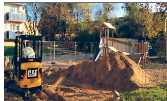
Einbau neuer Spielgeräte
