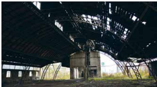
Die Borsighalle am Finowkanal in Eberswalde steht seit 2014 auf der Liste national wertvoller Kulturdenkmäler.
