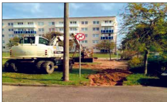
Entfernung des alten Gehweges
