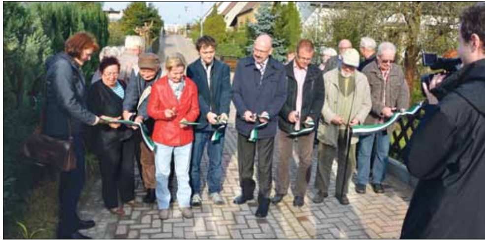
Gemeinsamer Banddurchschnitt mit Bürgermeister Friedhelm Boginski (Mitte) zur Fertigstellung der Straße im Eschenweg (v.l.): Tiefbauamtsleiterin Heike Köhler, Margot Roweda, Theodor Henning, Regina Elseberg, Asphalt-Planer André Vtilensky, Tharo-Geschäftsführer Matthias Uffrecht, Anwohner Hubertus Kerstan sowie Wolfgang Sachse, Vorsitzender des Eberswalder Bauausschusses.
