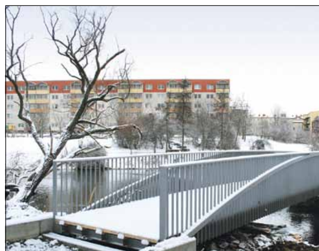
Die Schwärzebrücke, noch nicht begehbar.
