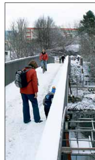
Die Leibnizbrücke kann wieder genutzt werden.
