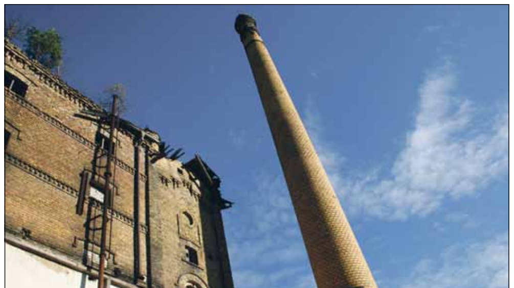
Schornstein und altes Sudhaus der Brauerei in der Eisenbahnstraße.
