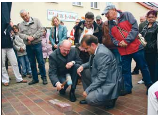
Minister und Bürgermeister setzten gemeinsam die letzten Gehwegsteine an der Poratzstraße.
