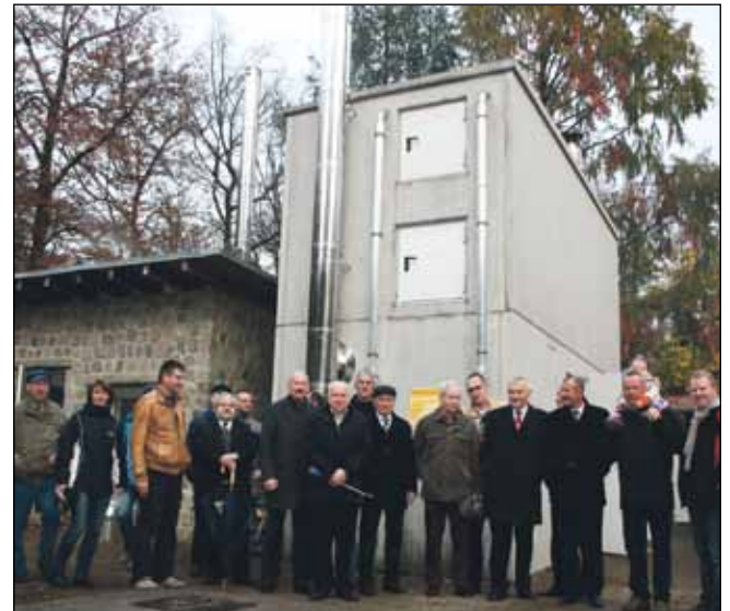
Stadtverordnete und Stadtverwaltung nahmen die neue Holzpelletheizung auf dem Wirtschaftshof des Eberswalder Zoos in Betrieb.
