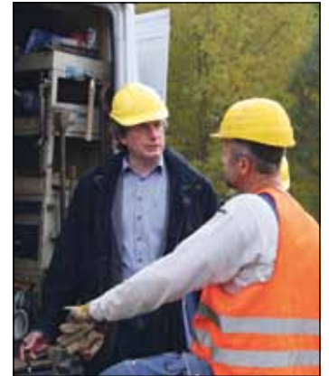
Andreas Wahoff (TÜV Nord), Jens Lehmann (Mitarbeiter TW) auf einer Baustelle
