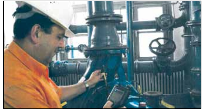
Uwe Liebke, Mitarbeiter der Fa. Uthhoff & Zarniko GmbH, bei der Schwingungsmessung.
