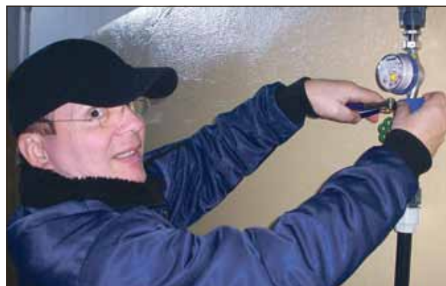
ZWA Mitarbeiter Gerd Bobermin verplombt den ausgewechselten Gartenwasserzähler eines Kunden.
