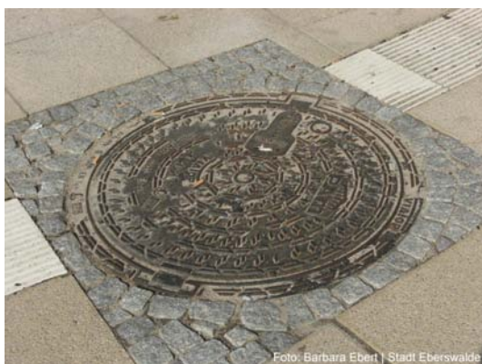
☹ Leitlinie, durch Gullydeckel unterbrochen
