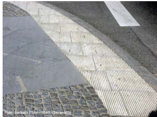
☹ Fehlerhaft angelegte Bodenindikatoren, zu großer Einmündungsradius, Unfallgefahr
