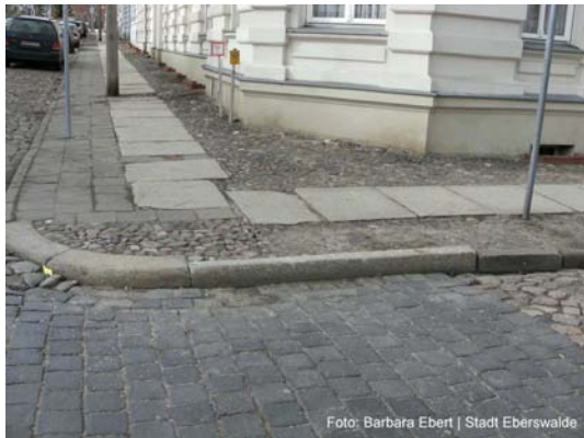
☹ Desolater Fußweg, ohne Bordsteinabsenkung an Querungsstellen
