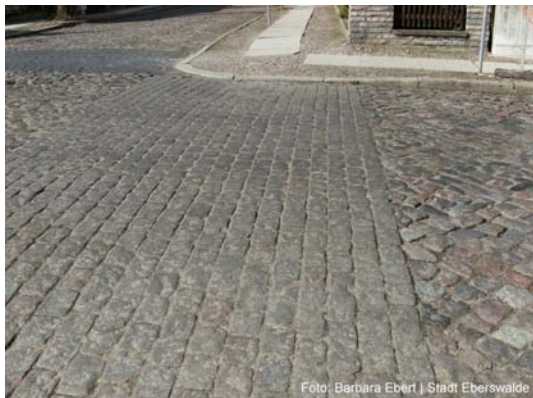
☺ Vorbildlich verlegtes Pflaster an Querungsstelle
