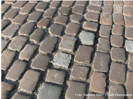
☹ Stark frequentierte Querungsstelle mit breiten, tief ausgewaschenen Fugen
