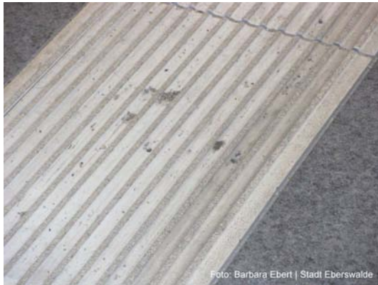
☺ Talbündig verlegte Rippenplatten, optischer Kontrast
