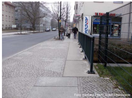
☹ Unterbrechung der Gehbahnmarkierung - fehlende Mobilitätskette
