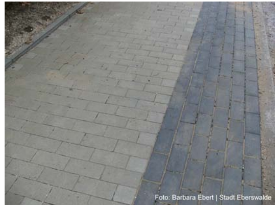
☹ Fehlender taktiler Kontrast zwischen Gehbahn und Sicherheitsstreifen
