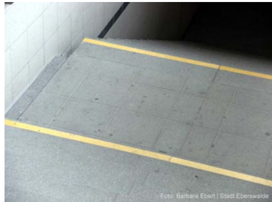
☺️ Stufenmarkierung auf Antritts- und Austrittsstufe
