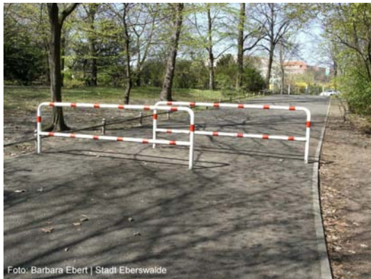
😊 Durchfahrssperre in Parkanlage mit optischem Kontrast
