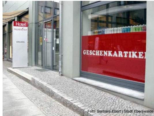
☹️ „Rampe“ mit Absturzgefahr
