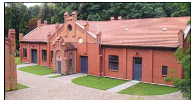
Wasserwerk Stadtsee nach der Sanierung.
