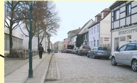
Straßensanierung, Östliche Brautstraße
