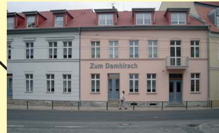
Gebäudesanierung, Breite Straße 53
