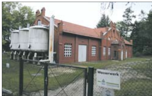
Wasserwerk Stadtsee im denkmalgeschützten Gebäude.
