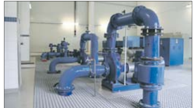
Sanierte Filterhalle im Wasserwerk Finow.
