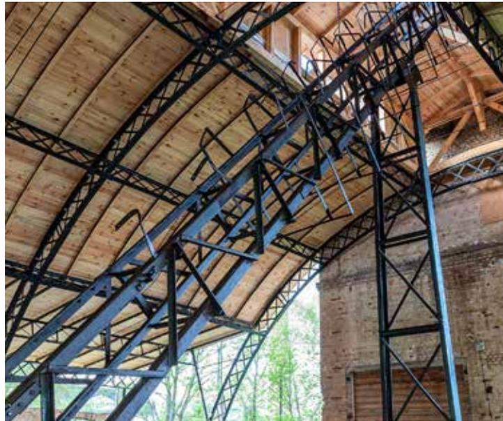
Abb. 11: Auf dem noch erkennbaren Schrägaufzug gelangte Braunkohle in die Schütten im obersten Geschoss des Gasgeneratorenhauses zur Gaserzeugung.
