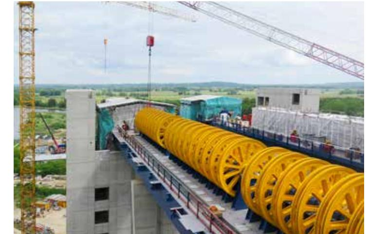
Abb. 10: Offene Seilrollenhalle des neuen Schiffshebewerks Niederfinow, Archiv Wasserstraßen-Neubauamt Berlin
