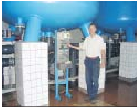
Herr Boden in der sanierten Filterhalle des Wasserwerkes
