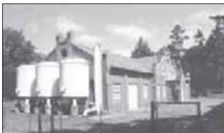
Blick auf das Wasserwerk am Stadtsee.
