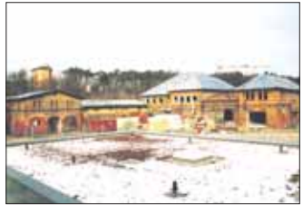
Blick aus dem Gropiusbau in den Hof zur Baustelle Kinder- und Jugend-Psychiatrie.
