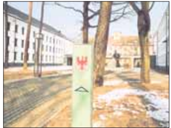
Die beiden sanierten Blöcke des Finanzamtes. An der Stirnseite lugt das künftige Schulamt durch den Kiefernbestand.
