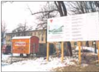
Baustelle Kriminaltechnisches Zentrum des LKA.
