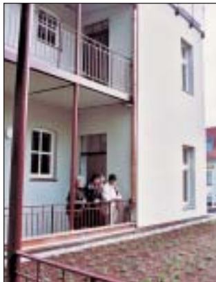
Moderner Laubengang im Hof.
