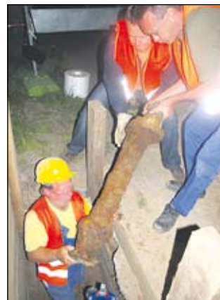
Der 75-jährige Hydrant wird mit vereinten Kräften aus der Grube gezogen.
