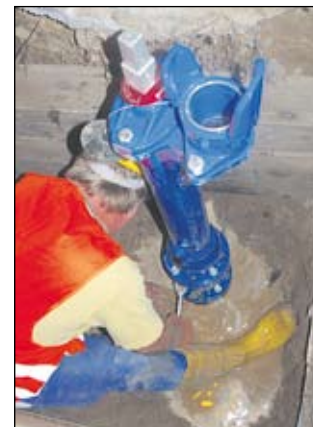
Montage der neuen Zapfstelle, wieder im Wasser. Gut, dass es Sommer ist!
