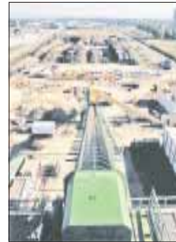
Freuen sich über den sichtbaren Baufortschritt des HOKAWE: TWE-Geschäftsführer Horst Schaefer (l.) und Dr. Martin Berz, Bauherr des Biomassekraftwerkes in ca. 33 m Höhe auf dem Dach des Komplexes. Blick auf das HOKAWE. Foto rechts: Transportband zur Bestückung mit Holzhackschnitzeln. Am Fuße des Bandes entsteht für diese brennbereiten Produkte eine überdachte Freifläche über 2.500 m 2 . Fotos:Stö.-
