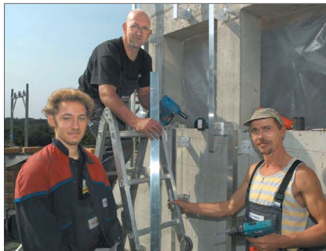
Am Aufzugsschacht West arbeiten Christopher und Benno Kirsch (Sohn und Vater) sowie Peter Sibilski (v.l.n.r.) Foto: Textfabrik/Lillge
