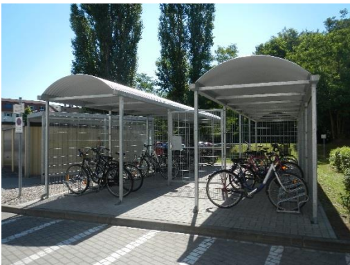
Überdachte und abschließbare Abstellanlage mit Felgenklemmern vor der Agentur für Arbeit, Bergerstraße
