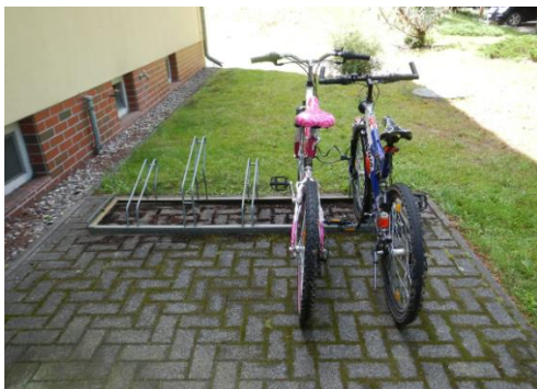
Anlage mit ungeeigneten Felgenklemmern ohne Witterungsschutz
