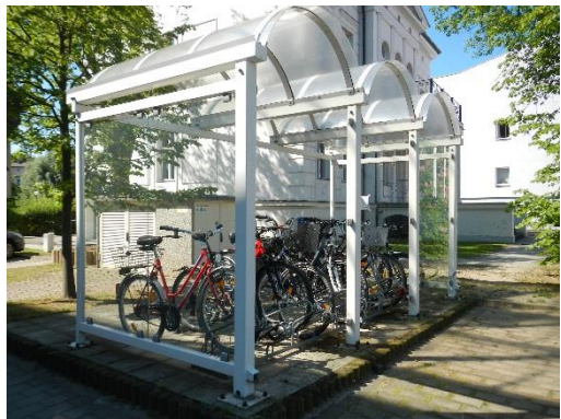
Überdachte und abschließbare Abstellanlage mit Felgenklemmern vor der Sparkasse, Eisenbahnstraße
