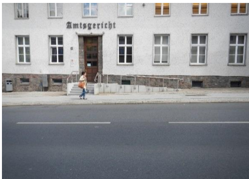
Fehlende Abstellanlage vor dem Amtsgericht
